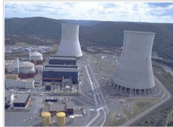
La centrale thermique à Safi devra produire en régime de croisière 10 milliards de Kwh par an, ce qui représentera 27% de la demande globale du Maroc à l'horizon 2014. (Photo : www.sciences.univ-nantes.fr )
